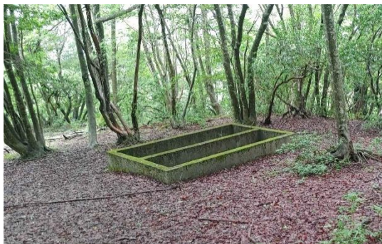
バンガロー跡の基礎コンクリート
