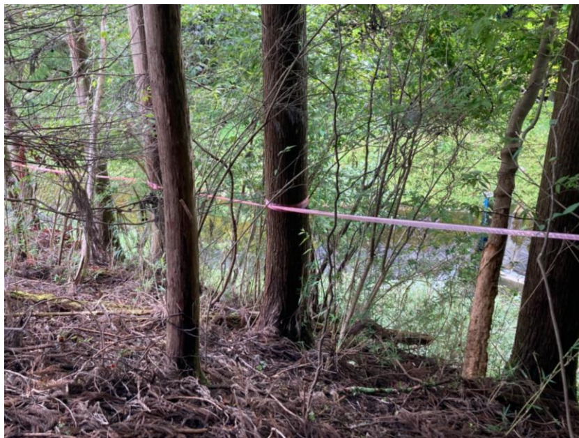
土崖（高さ約3m）
