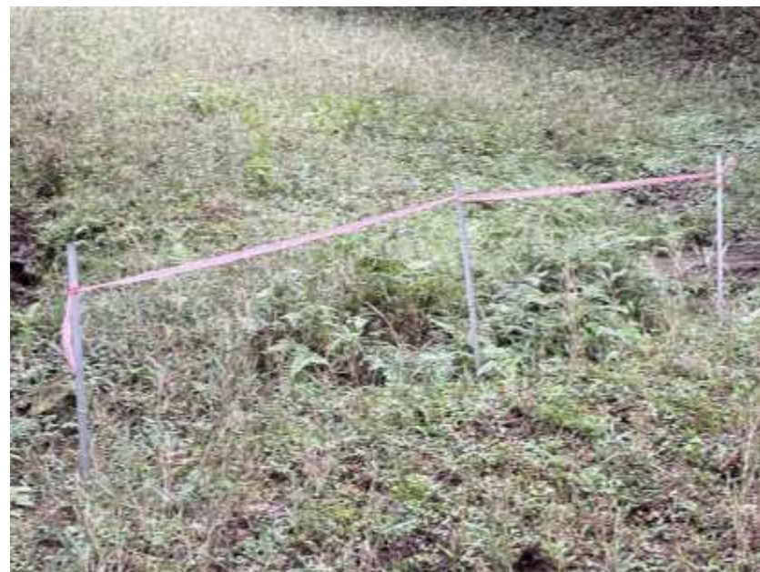
下草で隠れた溝
