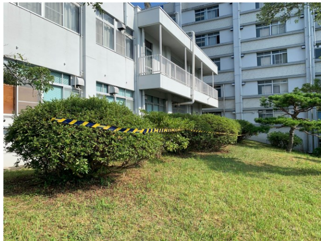
青黄テープを巻いた通行不能箇所
