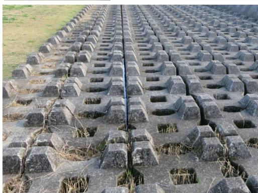
下記の減勢護床ブロック(水流の勢いを抑えるためのブロック)は、以下の記載をしています。
