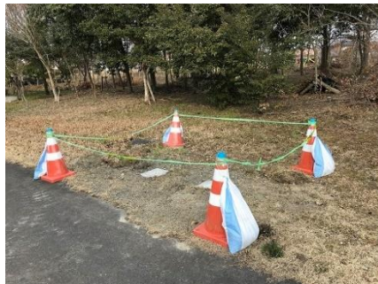
工事中立入禁止
